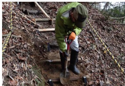
四季の森コース修繕の様子
