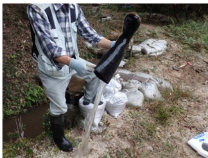
沢の堰堤補修作業 10月後半
