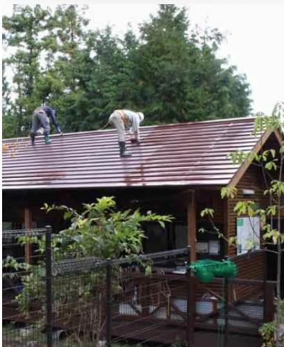
楽舎屋根塗装 10月20日 Photo 藤本H
