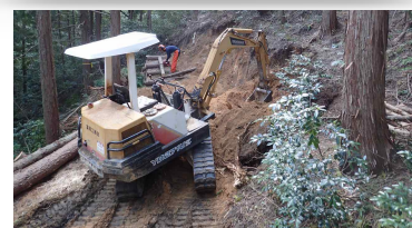
路面掘削と路肩補強 10月14日
