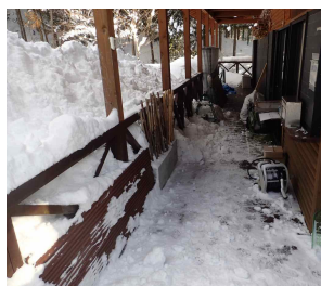
屋根落雪が通路に入り込む 2/6
