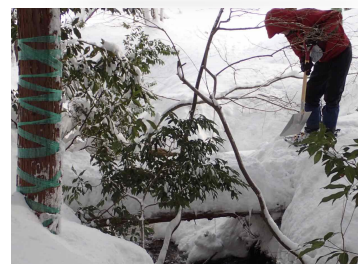
沢道木橋の除雪 2/6
