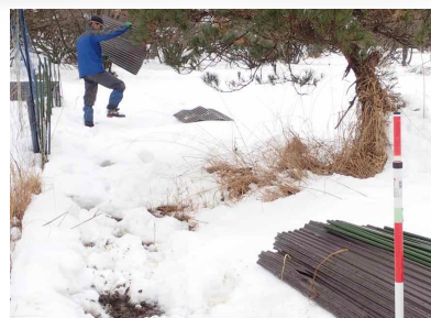
防獣トタンの解体撤収 2017.12.12
