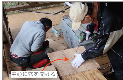
沈み込み防止板を作成
