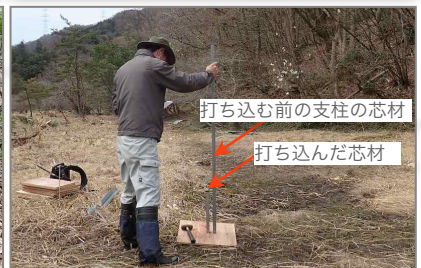
湿地は柔らかく、支柱は簡単に沈む
