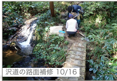
階段部材の交換 10/16
